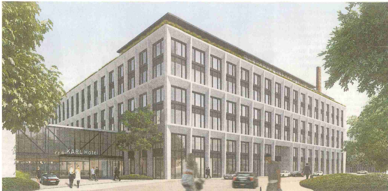
Die neu errichtete Shedhalle soll als Vorfahrt und Eingang zum Hotel dienen. Quelle: Karl München GmbH & Co.KG
