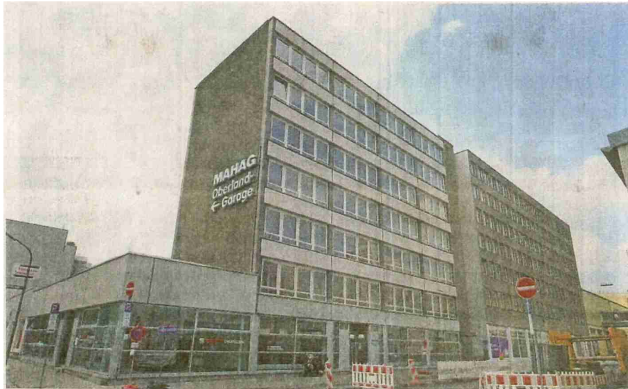
Nicht mehr gebraucht: Der leer stehende Mahag-Komplex muss dem Neubau weichen.
